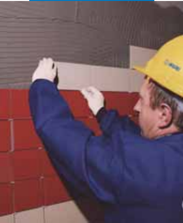
Укладка керамической плитки на стену
